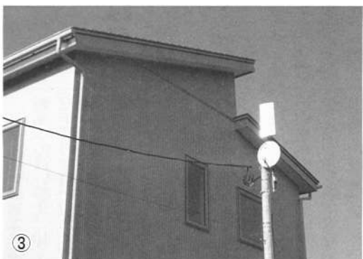
写真①オープンした石川スタジオ、北電の協力で電気自動車も展示。写真②の檜山産の道産杉を用いたエントランス周り、写真③5kW以上の大容量な太陽光パネルを搭載する勾配屋根。TVアンテナには発電に影響を及ぼさない壁掛け式を採用、写真④和室の外に坪庭風のウッドデッキ、写真⑤雨樋に連結して雨水利用タンクも
